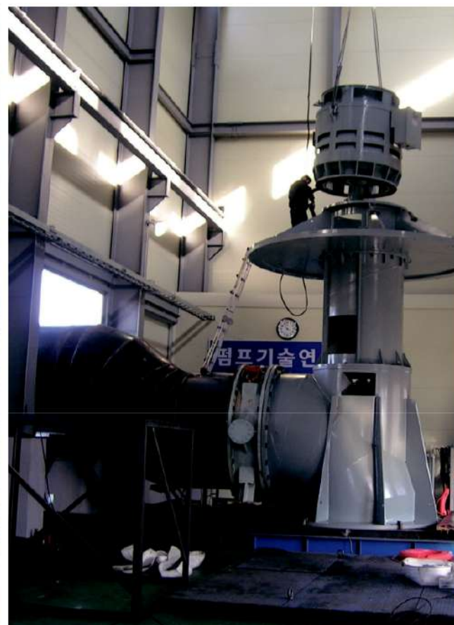
Vận hành thử nghiệm bơm trực đứng
