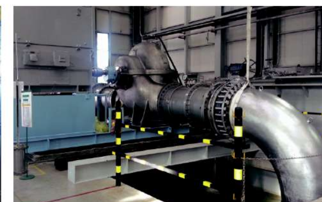
Vận hành thử nghiệm bơm hút đôi
